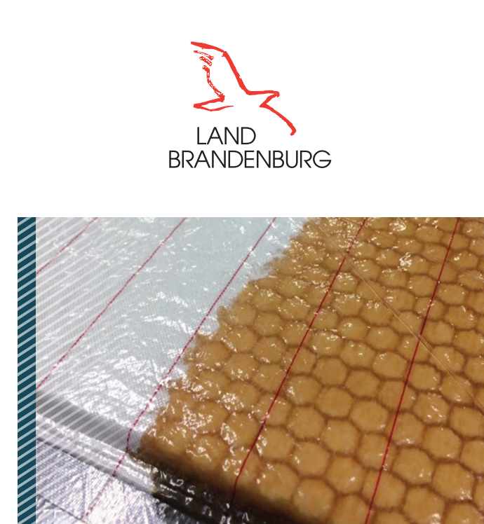
Das Material für die Schachtsanierung - rechts mit Harz zwischen den Schichten.
