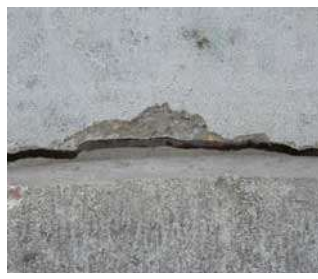
Abplatzungen im Muffenbereich und an der Schachtwandung
