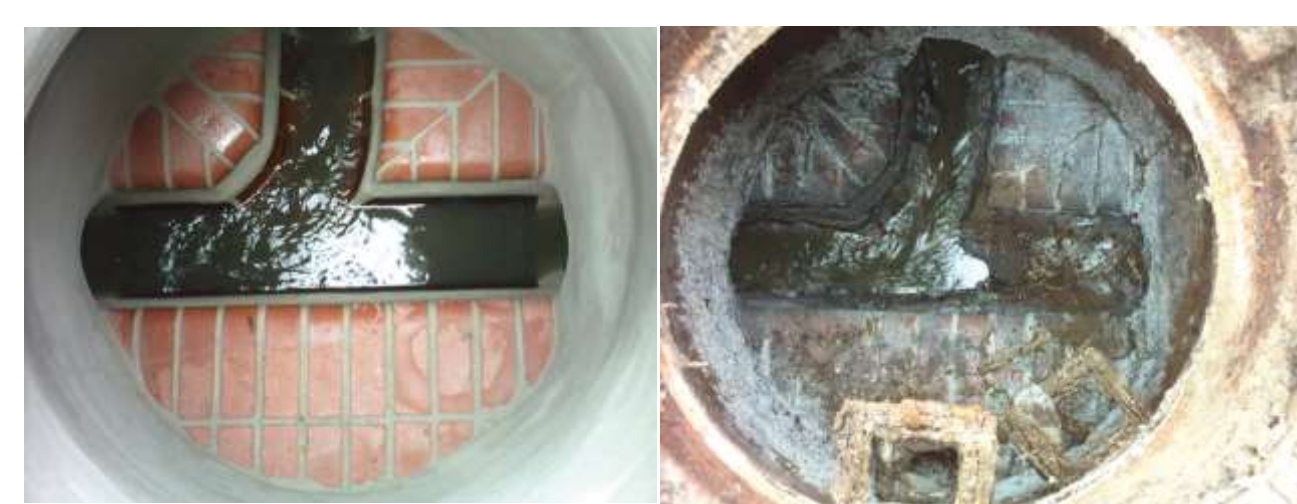
Biogene Schwefelkorrosion im Schachtboden
