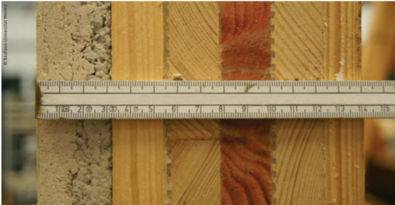
© Bauhaus-Universität Weimar Äußerst belastbar und gut fürs Raumklima: Für die Holz-Anhydrit-Verbundsysteme der Bauingenieure an der Bauhaus-Universität Weimar wird das gipsähnliche Anhydrit direkt auf Holz aufgetragen.
